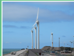
Bientôt, une éolienne plus grande et plus performante
