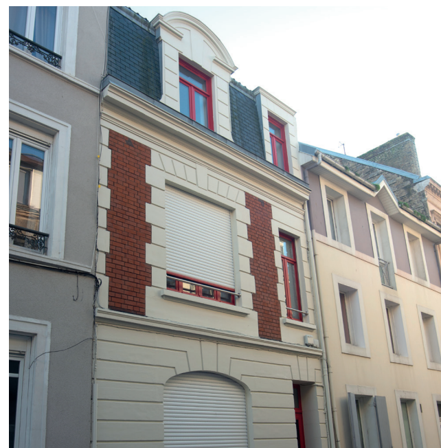
Restructuration lourde d'un logement rue Leuliette à Boulogne-sur-Mer
