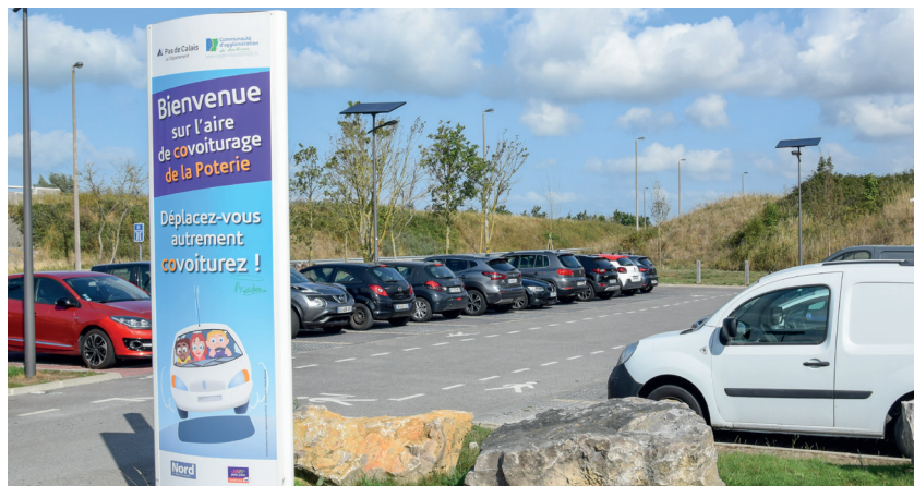
AIRE DE LA POTERIE – échangeur 32 – A16 : 45 places, 3 places PMR et 1 abri pour les vélos + l'extension : 23 places supplémentaires dont 2 places PMR.
