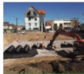
Pendant les travaux
