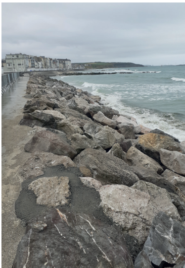
Reprise des enrochements de la digue Nord de Wimereux
